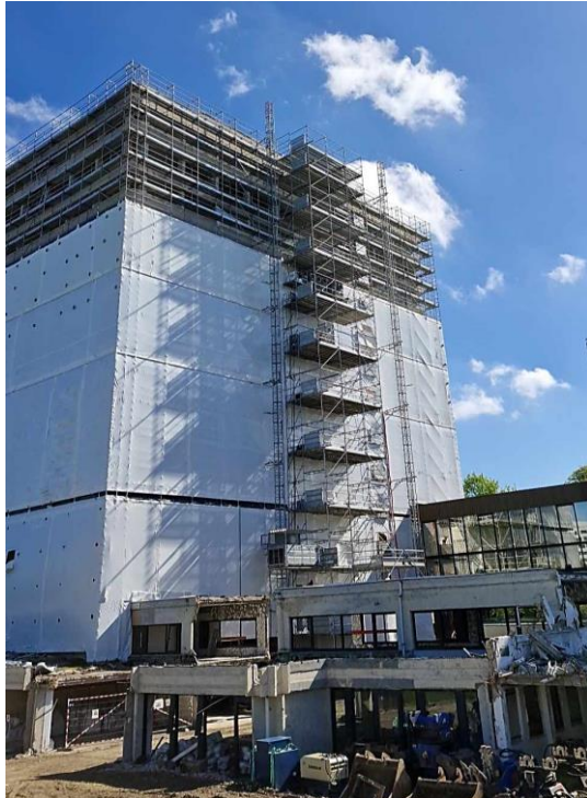
Chantier de réhabilitation de la MEL par VALGO @Renard/FabienCoisy
